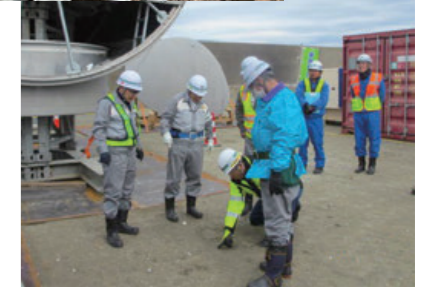
安全パトロールの様子
