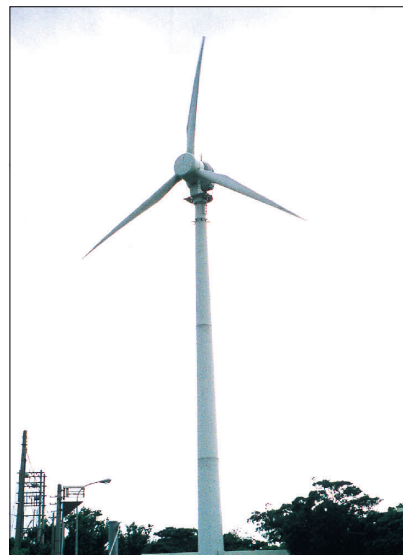
風力発電機 (280kW)
